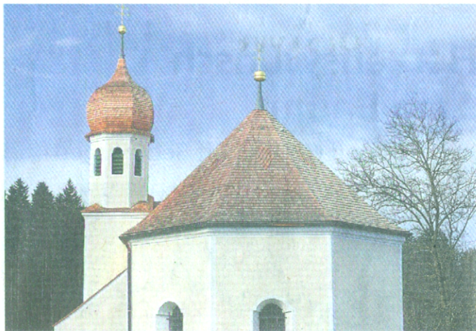
Neues Dach, frischer Anstrich: Die St.-Nikolaus-Kapelle wirkt wie aus dem Ei gepellt.
