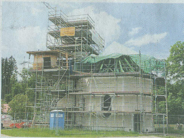
Sanierung: Die Arbeiten am Dachstuhl der St. Nikolaus-Kapelle sind in vollem Gange.
