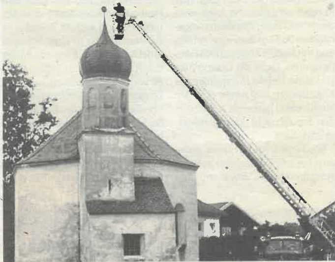
Erste Renovierung: 1967 wurde das durch Blitzschlag stark beschädigte Doppelkreuz von der Feuerwehr Geretsried geborgen. Fotos: Otto Rothe
